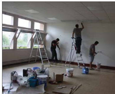
Deux salles de classe ont été complètement refaites dans le groupe scolaire Auguste-Delaune.
