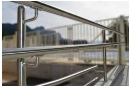
L'acier inoxydable A4, anciennement inox 316 L, est appelé communément inox marin. En effet, il est utilisé principalement dans l'industrie navale, pour l'équipement des bateaux, ports et aménagements côtiers pour son excellente résistance à la corrosion. Outre le chrome et le nickel, est ajouté, pour l'acier inoxydable A4, 2 à 3 % de molybdène qui a pour propriété d'augmenter la résistance à l'acide, au chlore et à la corrosion.
